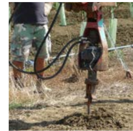
Driller per installazione ancore
