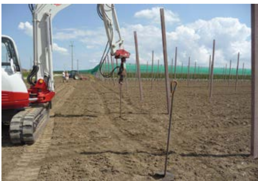
Installazione pali in cemento e ancore per frutteto
