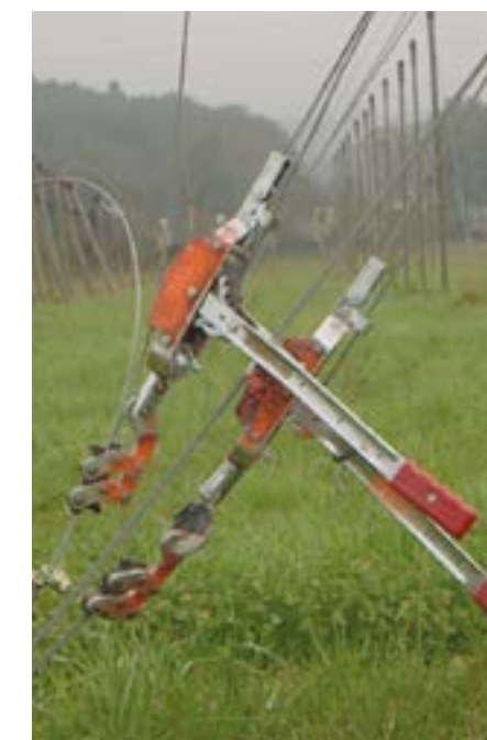
Tensionamento funi di struttura
