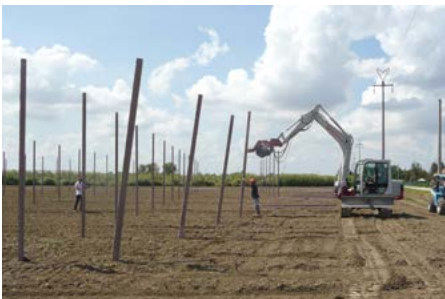
Impianto di pali e ancore con diversi strumenti.
